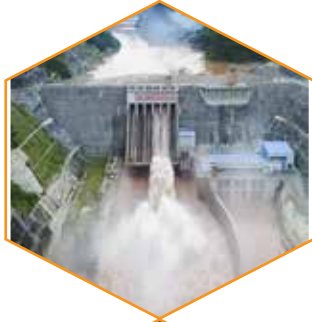
Nhà Máy Thủy Điện Hydropower plants
