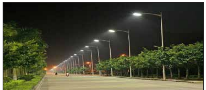
Hệ thống chiếu sáng cầu đường Lighting system for street, Bridge
